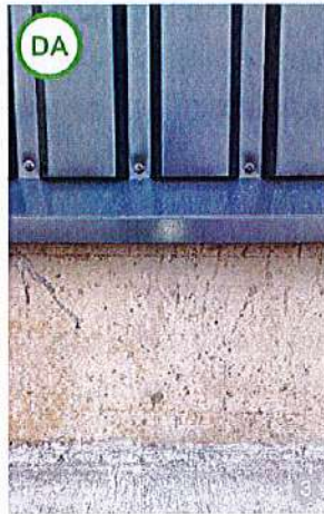
ASA DA: Soclu realizat din beton, cu finisaj aparent, protejat la partea superioară cu șorț de tablă. Trotuarul de protecție este realizat tot din beton aparent, cu finisaj perlat.
