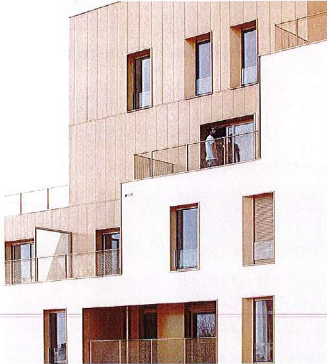
Exemple de tratări ale fațadelor - Accente de culoare. Sursa: TVK Architectes. ZAC du Chaperon Vert, Arcueil
