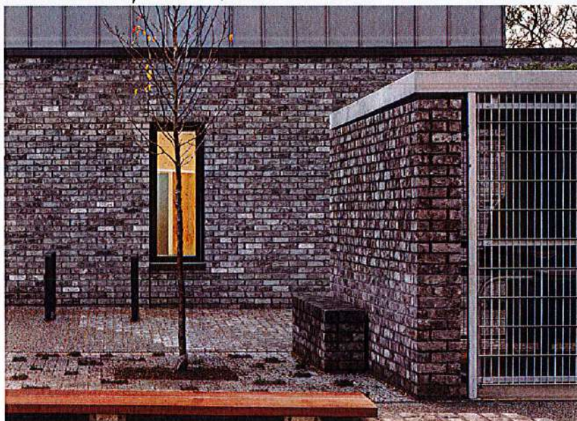
Exemplu de tratarea spațiilor destinate colectării deșeurilor într-o manieră similară funcțiunii principale. Sursă: Marmalade Lane, Cambridge
