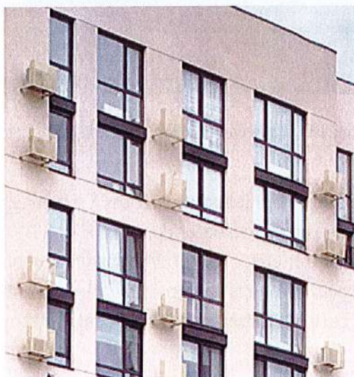
Exemplu de mascare a aparatelor de aer condiționat amplasate pe fațadă cu tablă perforată
