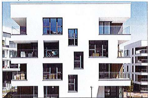
folosirea accentelor de culoare la nivelul balcoanelor (ce nu depășesc 15% din suprafața totală a fațadei) - DA
