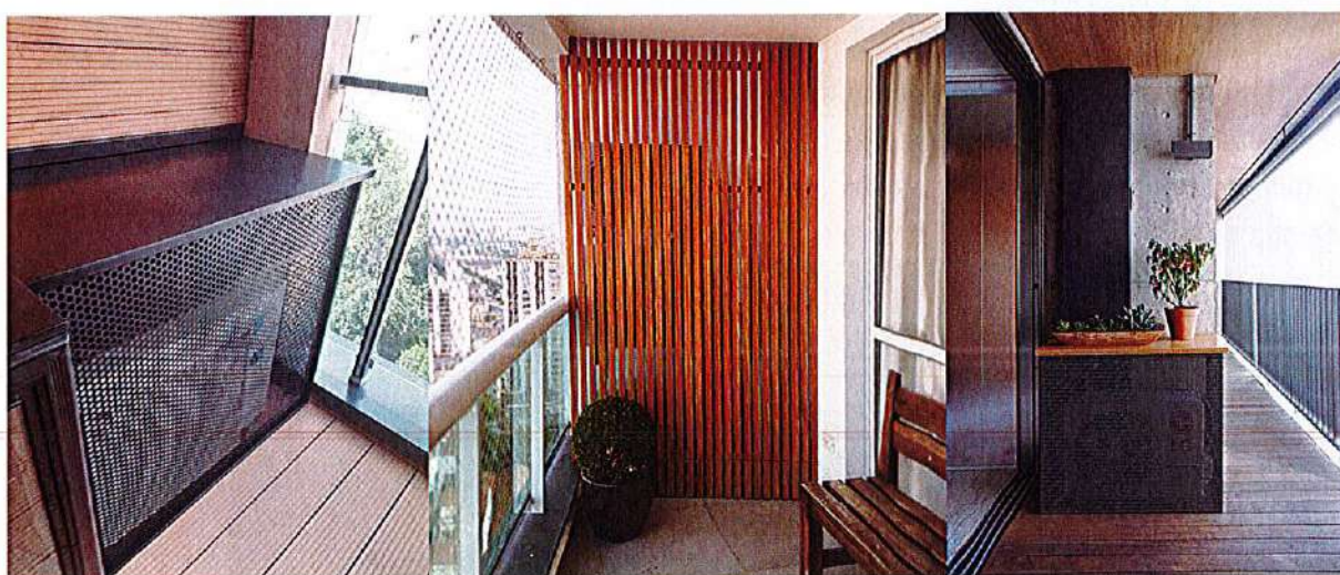
Exemplu de mascare a aparatelor de aer condiționat amplasate pe balcon. a. Tablă perforată b. Riflaj lemn
